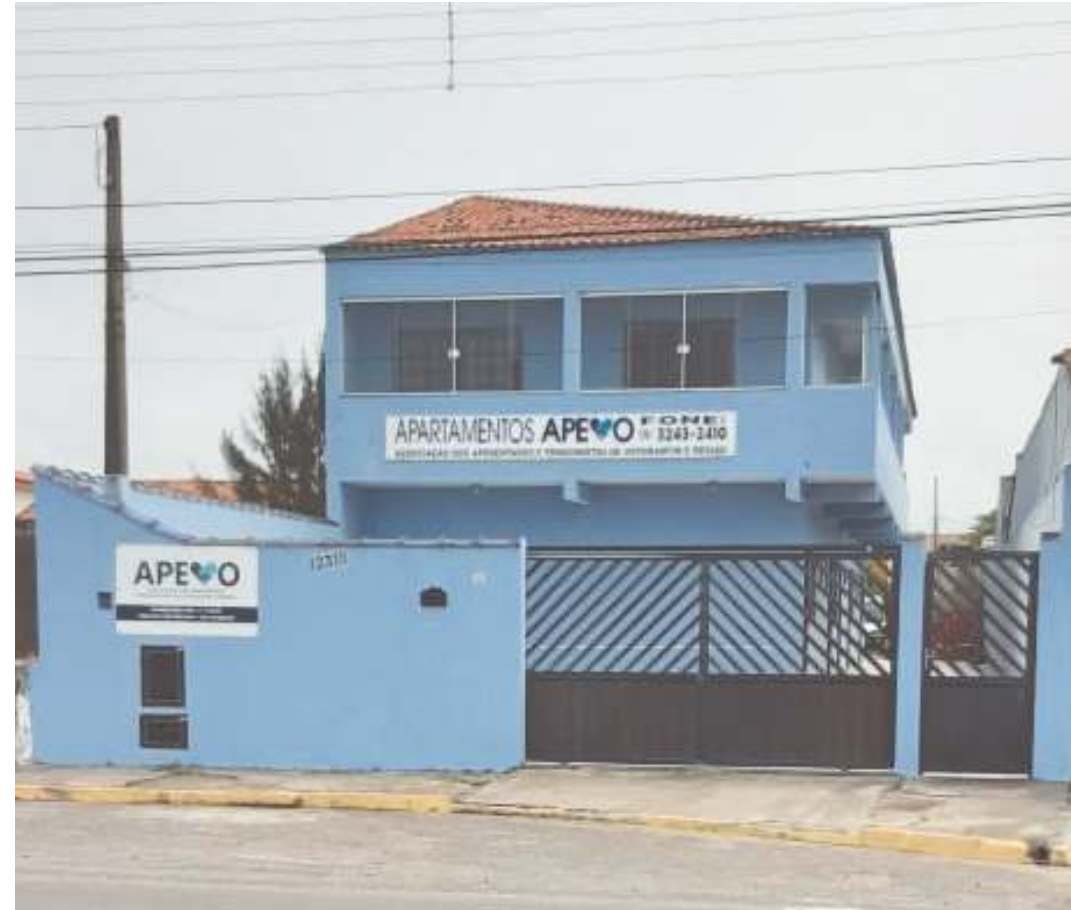
Obra de ampliação está na fase final
