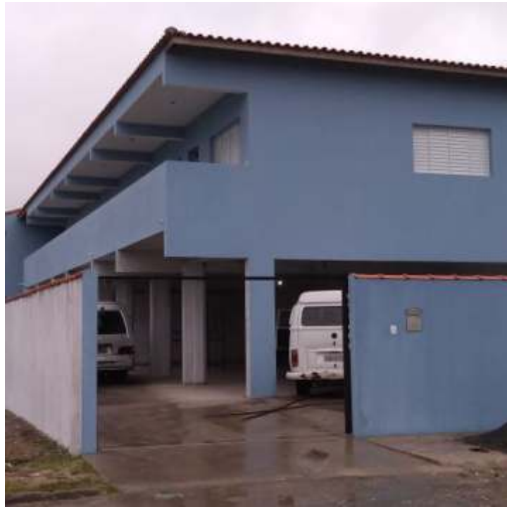
Obra deverá ser finalizada nos próximos meses
